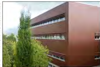
El IFISC, instalado en un edificio de la UIB.
